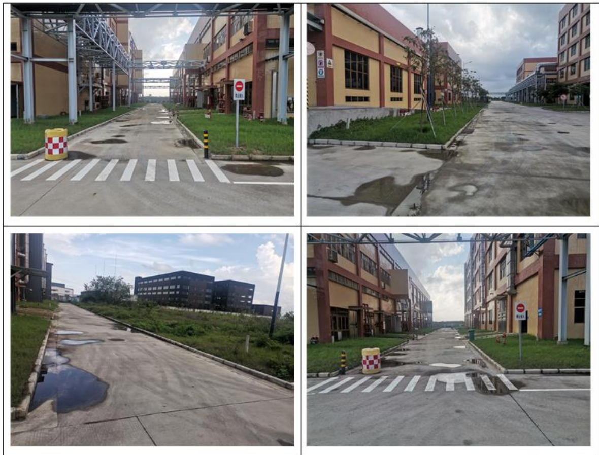
图 3-1 水土保持植物措施现状照片
